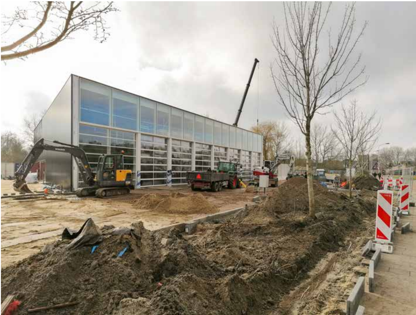
Werkzaamheden aan de noordgevelzijde.
