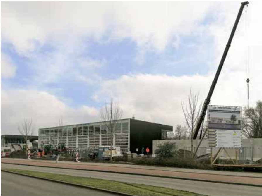
Dit voorjaar wordt het gebouw opgeleverd en in gebruik genomen.
